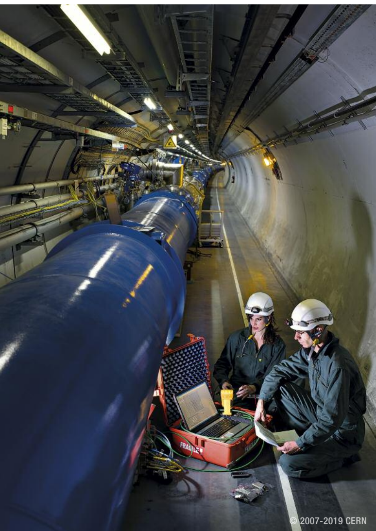
➤ 工程师测试一个LHC超级磁体的电气系统
