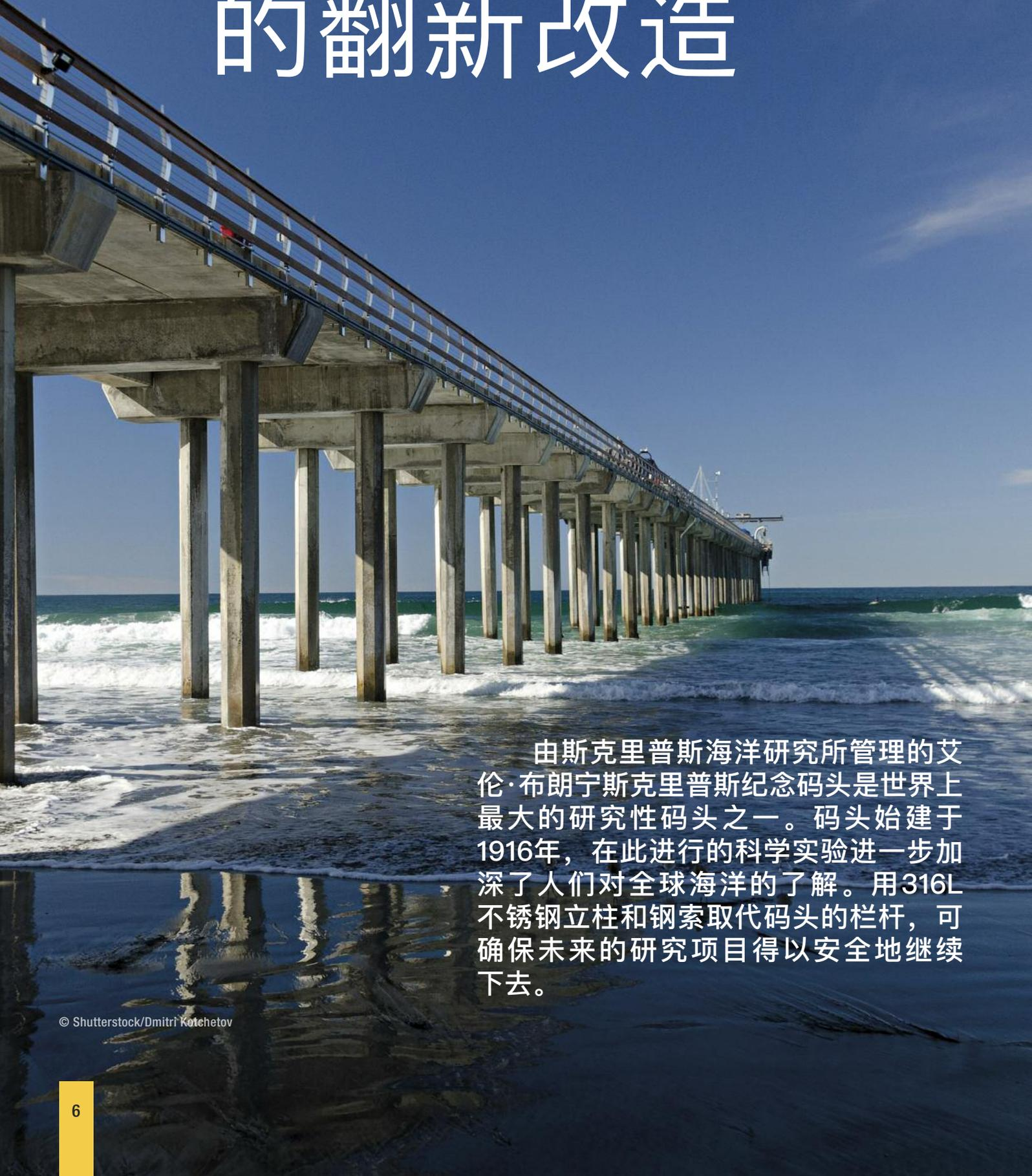
由斯克里普斯海洋研究所管理的艾伦·布朗宁斯克里普斯纪念码头是世界上最大的研究性码头之一。码头始建于1916年，在此进行的科学实验进一步加深了人们对全球海洋的了解。用316L不锈钢立柱和钢索取代码头的栏杆，可确保未来的研究项目得以安全地继续下去。
