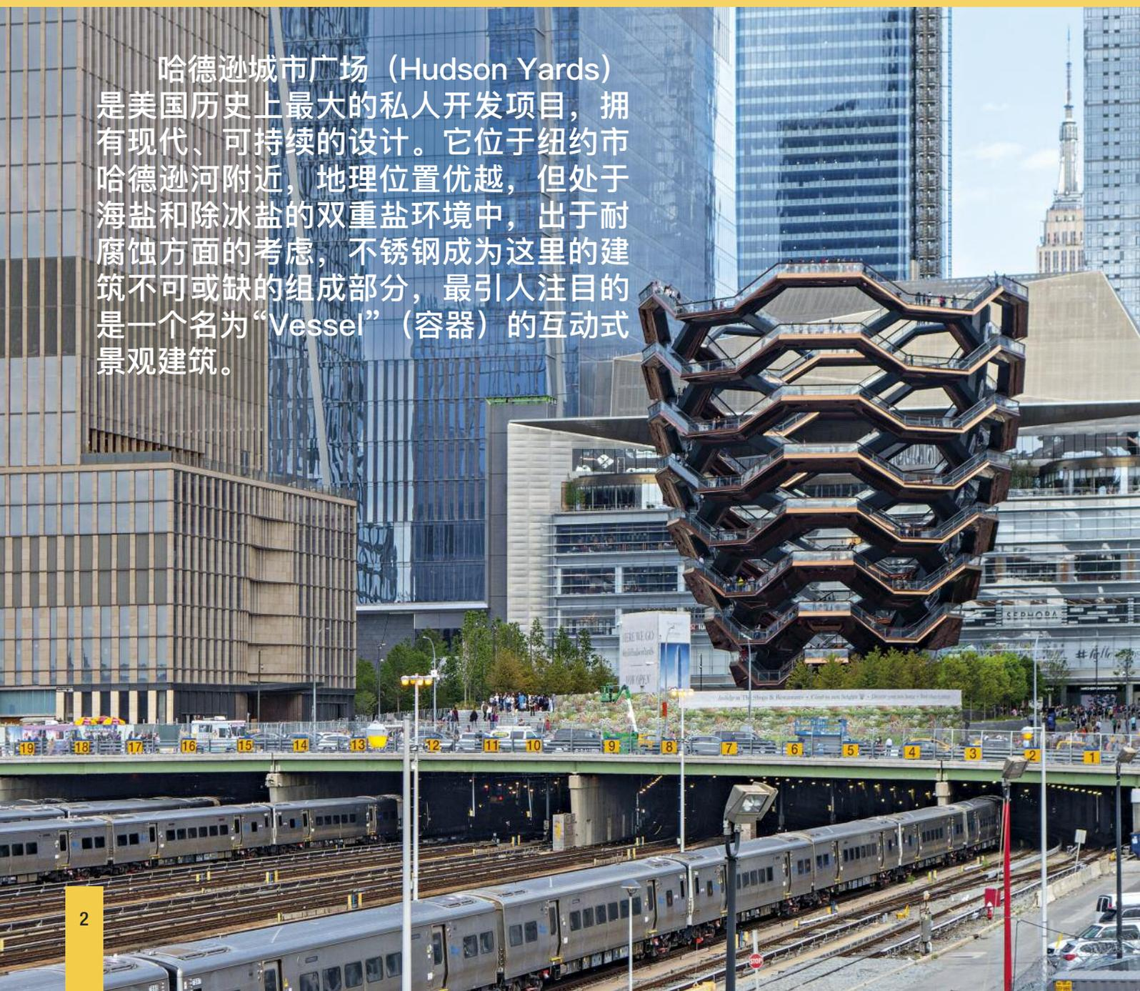
哈德逊城市广场综合开发项目自2012年正式动工以来，已经将一个繁忙的火车站场改造成了一个多功能的时尚别致的空间。该项目耗资250亿元，计划建设250万平方米的商业综合体、休闲娱乐设施、文化教育中心和住宅公寓，超过56000平方米的公共空间及绿地。部分建筑和结构拥有简洁的几何设计风格和熠熠生辉的外立面。多种建筑元素大量使用316L或2205不锈钢。316L不锈钢中2%的钼含量提高了耐腐蚀性，2205双相不锈钢的钼含量达到3%，耐大气腐蚀性能更好。纽约是沿海城市，而且使用大量的融雪盐，因此需要加强保护防止腐蚀性氯化物的侵蚀。因为冬季的主要风向会将附近哈德逊公园大道上的融雪盐吹向建筑所在位置，所以新建社区的融雪盐含量特别高。哈德逊广场项目一期包括“Vessel”地标建筑已于2019年首次向公众开放。
