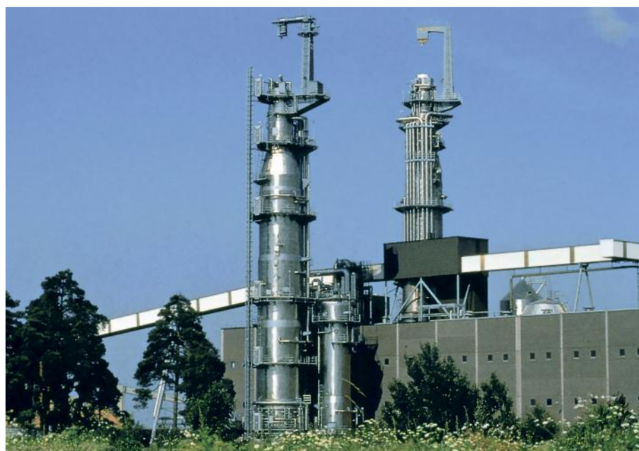
瑞典Sodra Cell Mönsterås纸浆厂的2205硫酸盐纸浆连续蒸煮器和浸渍塔 © Kvaerner Pulping
