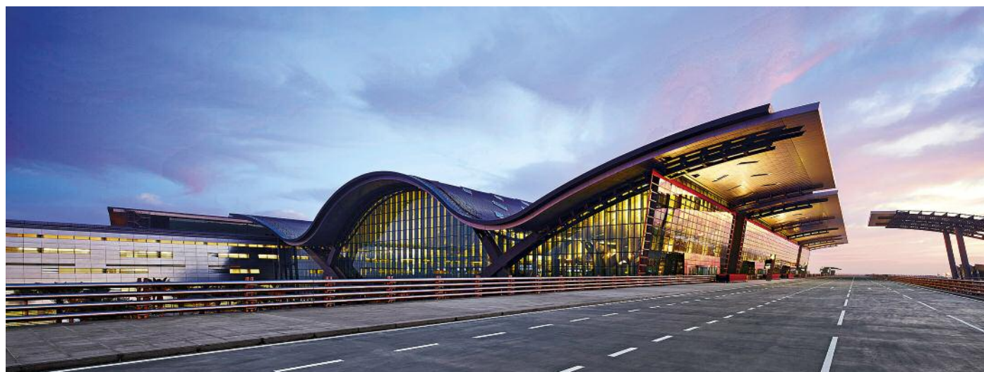
卡塔尔多哈哈马德国际机场航站楼的双相不锈钢屋面 © Hmad International Airport
