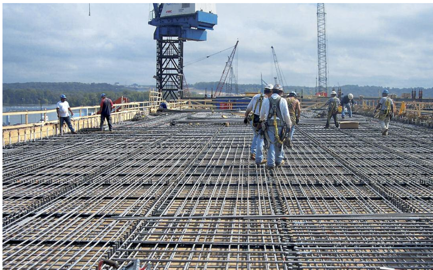
在一个大型桥面上安装双相不锈钢钢筋 © Hardesty & Hanover, LLP
