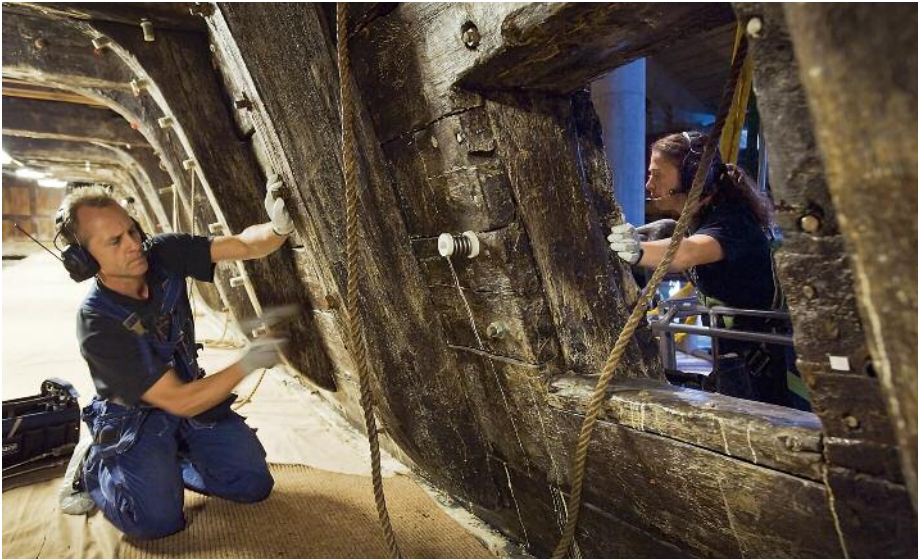
正在安装特超级双相不锈钢螺栓，保护瑞典的古沉船瓦萨战舰 © Anneli Karlsson 瑞典国家海事博物馆
