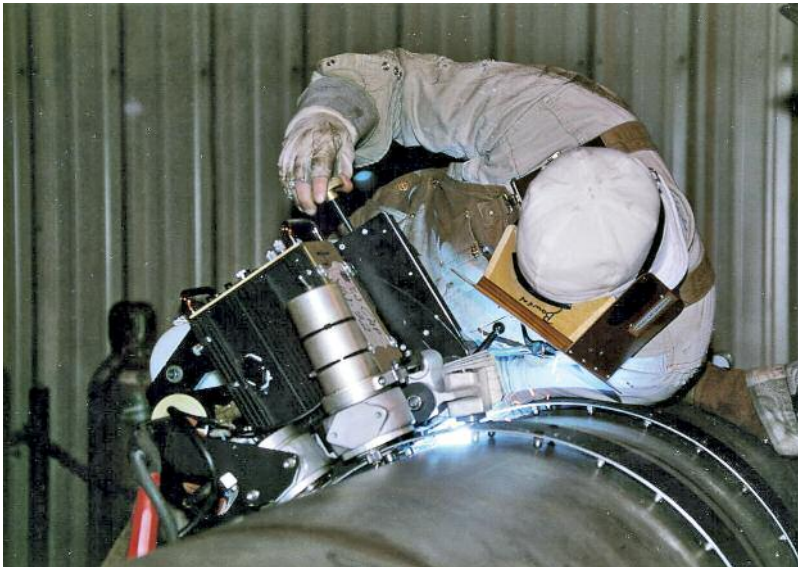
阿拉斯加北坡的大直径双相不锈钢管道的机械化焊接 © Arco Exploration and Production Technology
