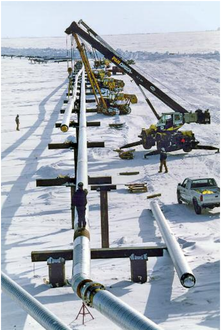
普拉德霍湾垂直支撑架上24英寸2205双相不锈钢保温管道的安装 © Arco Exploration and Production Technology
